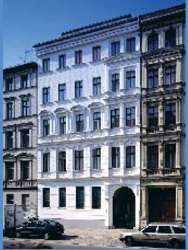
Sanierung und Umbau eines Mietshauses mit Ensembleschutz in Berlin
